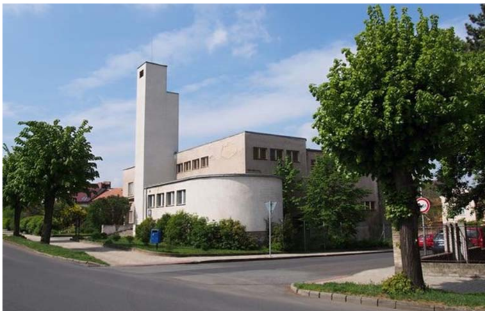
Evangelický kostel v Lounech, postavený v roce 1932 ve funkcionalistickém stylu podle projektu lounského architekta Pavla Bareše.
