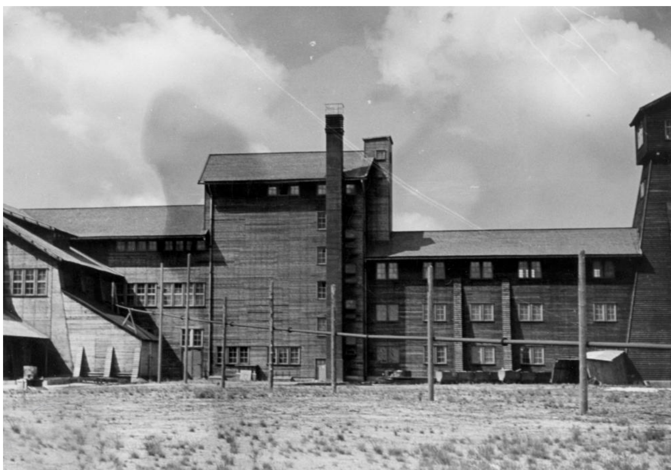
budova úpravny, vpravo těžní věž (objekty na mapě 55, 56, 57 a 58)
