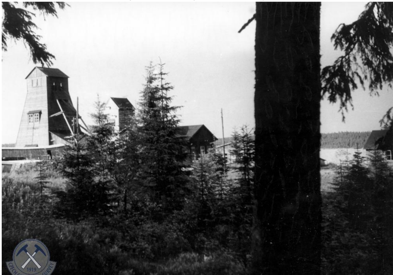
Šachta č.2, těžní věž, strojovna (cca 1km východně od továrny)
